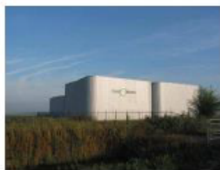
Nieuwe bedrijfsbebouwing opgebouwd uit damwandprofiel
