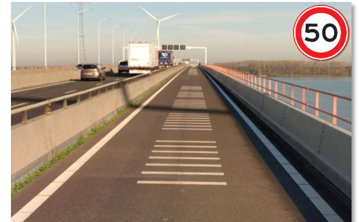
Figuur B1.6: Huidige inrichting van de parallelweg Haringvlietbrug
