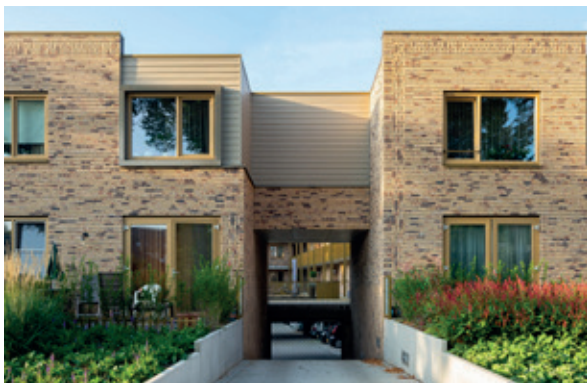
Ingetogen terugliggende entree parkeren, onderdeel van de architectuur
