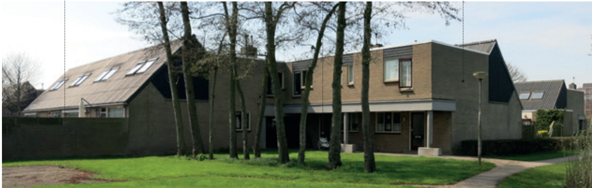
Toegang tot de tuin en woning
