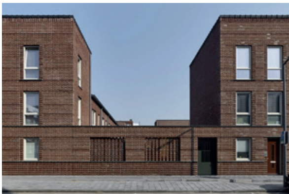
Blinde gevel met halfopen metselwerk (Braziliaans verband)
