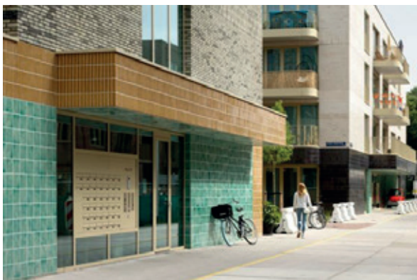
Entree als architectonisch element met kleur en uitstekend geveldeel
