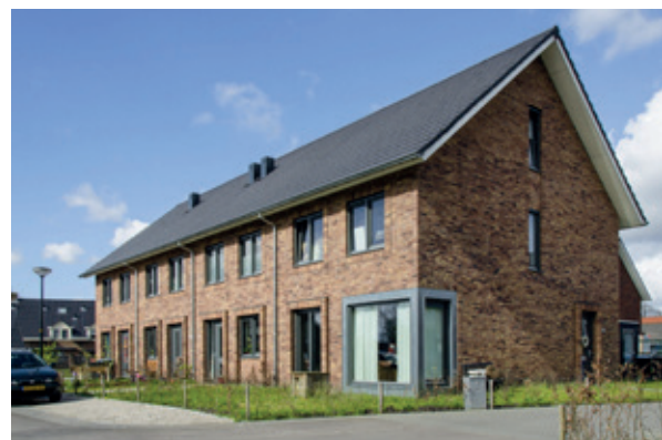
Kort bouwblok, afwijkende architectuur hoek, ramen en voordeur aan de kopgevel, afwijkend metselverband rond uitsparingen
