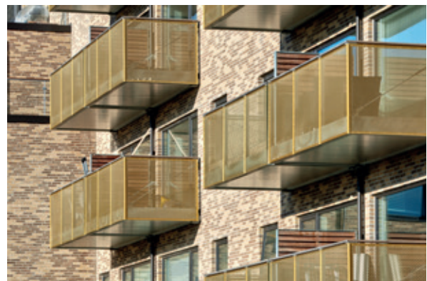
Semi-transparante reling door geperforeerde metaalplaten
