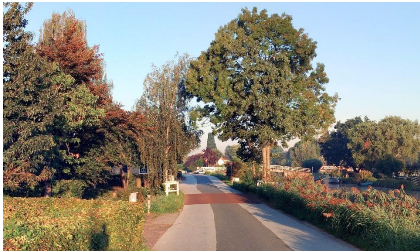
Voorbeeld van natuurlijk sturen: een visuele versmalling met brugleuningen en andere bestrating op de Abbekesdoel in Bleskensgraaf.
