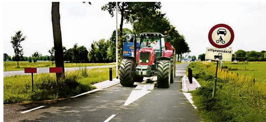
Figuur: voorbeeld van een landbouwsluit, hier houden landbouwvoertuigen en fietsers doorgang, personenauto's en vrachtwagens mogen hier niet door
