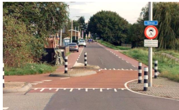
Figuur: voorbeeld van selectieve toegang bij de Stougesdijk, enkel bestemmingsverkeer mag over deze dijk rijden (maar is niet 100% 'waterdicht')
