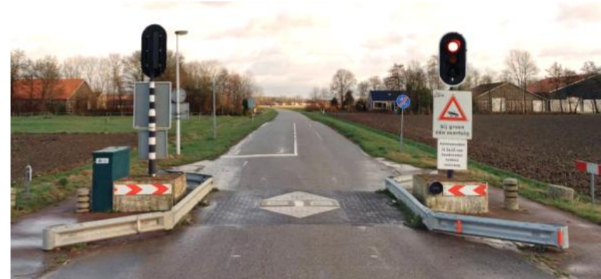
Figuur: voorbeeld van een push-maatregelen, een doseerpunt waar niet-bestemmingsverkeer enige tijd moet wachten (bij groen: 1 voertuig tegelijk)
