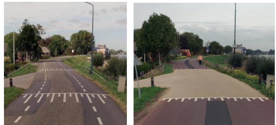
Figuur: herinrichting van een dijkweg in Andel volgens het natuurlijk sturen principe (bron: Streetsmart Cyclomedia)
