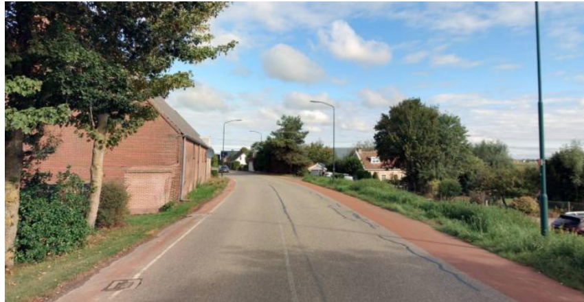
Figuur: de Stougjesdijk heeft een brede rijbaan met smalle fietsstroken, waardoor autoverkeer hier vaak hard rijdt, en het minder prettig fietsen is
