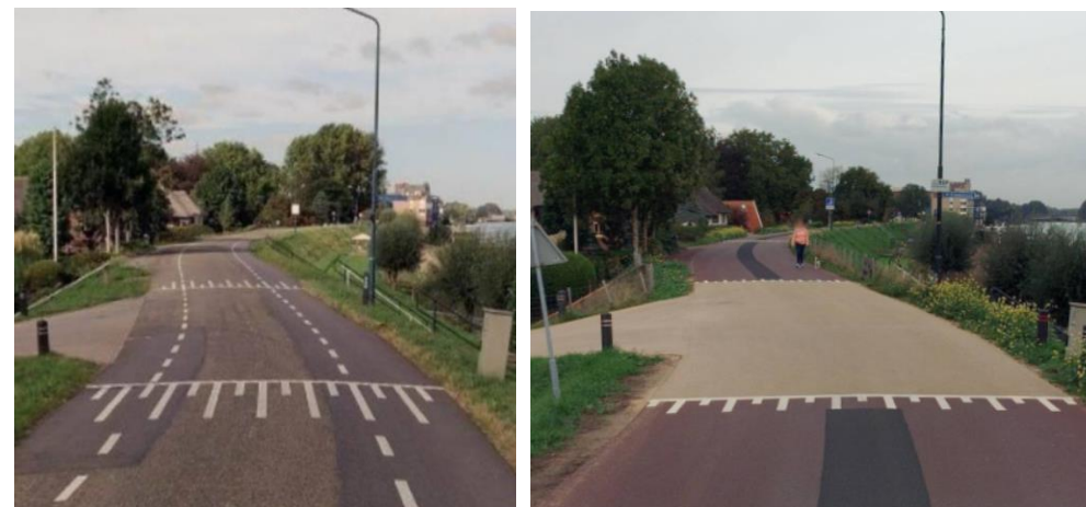
Figuur: herinrichting van een dijkweg in Andel volgens het natuurlijk sturen principe (bron: Streetsmart Cyclomedia)
