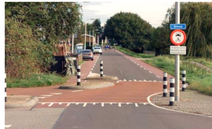
Figuur: voorbeeld van selectieve toegang bij de Stougjesdijk, enkel bestemmingsverkeer mag over deze dijk rijden (maar is niet 100% 'waterdicht')
