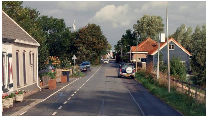
Figuur: veel voorkomende inrichting van een dijkweg met asfalt, fietsstroken, geparkeerde auto's in de wegwand, en dijkwoningen dicht op de weg
