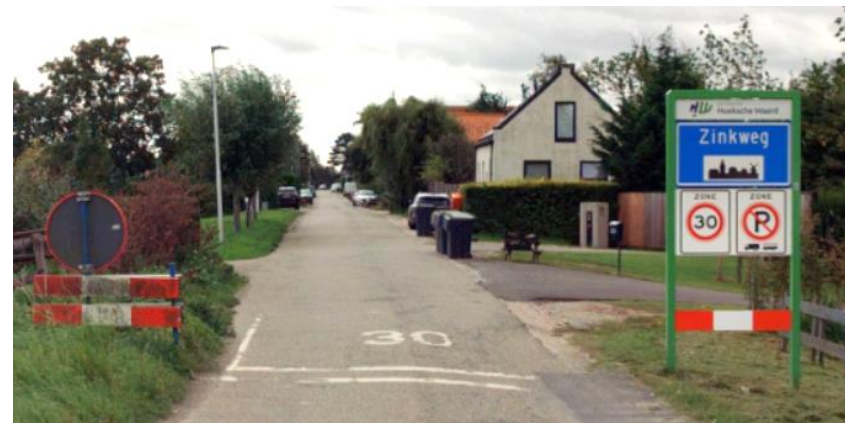
Figuur: de komgrens kan meer aangekleed worden om te benadrukken dat men een woongebied in rijdt, en de snelheidslimiet terug gaat van 60 naar 30 km/u
