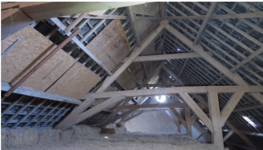
Afbeelding 9: Het grootste deel van het dakvlak van de schuur bestaat uit dakpannen die direct op de panlatten liggen, hierachter bevindt zich de open zolderruimte. Onder bepaalde dakdelen zijn platen aangebracht.
