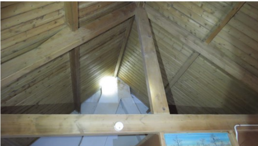
Afbeelding 13: Zolder van het woonhuis gedeelte van de boerderij. Hier zijn geen sporen aangetroffen die duiden op aanwezigheid van grootoorvleermuizen.
