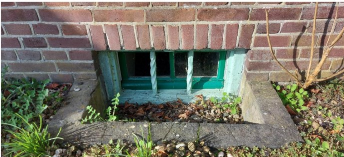
afb. 19 De linker zijgevel van het woonhuisgedeelte van Even Buiten
