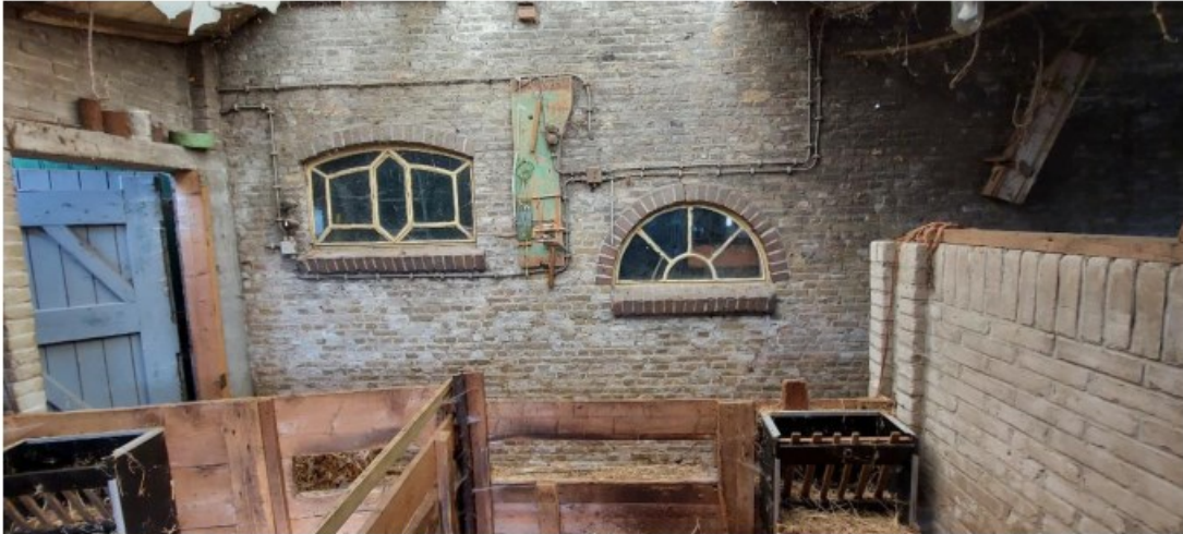
afb. 33 De achtergevel van het bedrijfsgedeelte, begane grond, gezien vanuit aanbouw D
