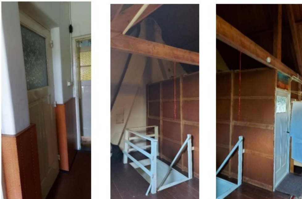
afb. 27 De verdieping van het woonhuisgedeelte met links de toegangsdeur tot de verdieping vanuit de dwarsgang, zicht op de achterwand met schoorsteenkanalen, traphek en inbouwkamer en rechts de toegangsdeur tot de inbouwkamer die tegelijk met het dakvenster is ingebracht.
