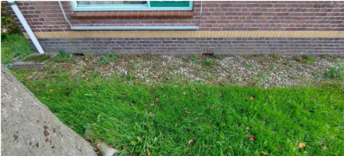
afb. 53 Grindbed langs de rechter zijgevel van het woonhuis
