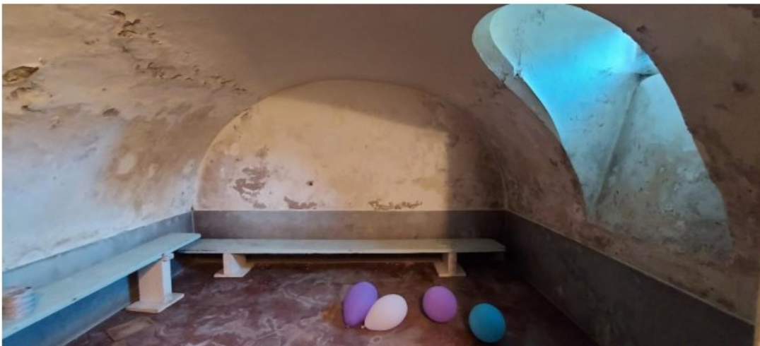
afb. 25 De kelder; de deur naar de kelder in de keuken, de enkelvoudige balklaag en het tongewelf gezien richting het noorden
