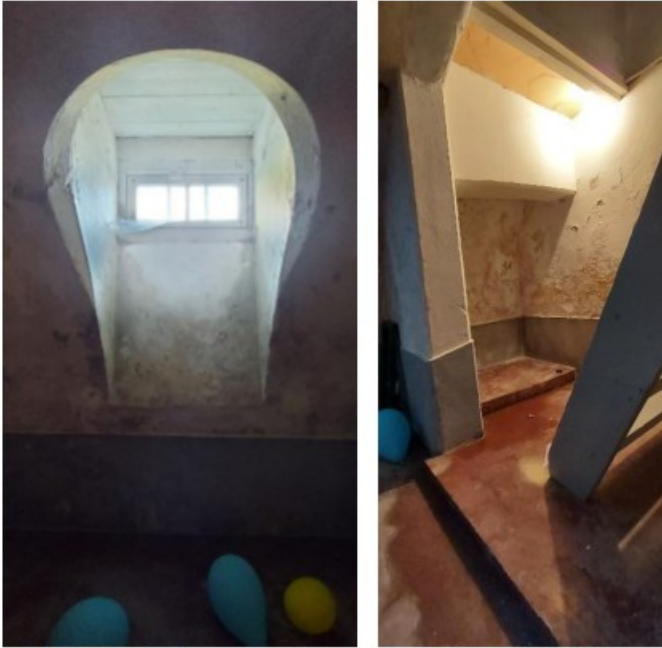
afb. 26 De kelder; het kelderraam met diefijzers en zicht vanuit de kelder naar het trapportaal
