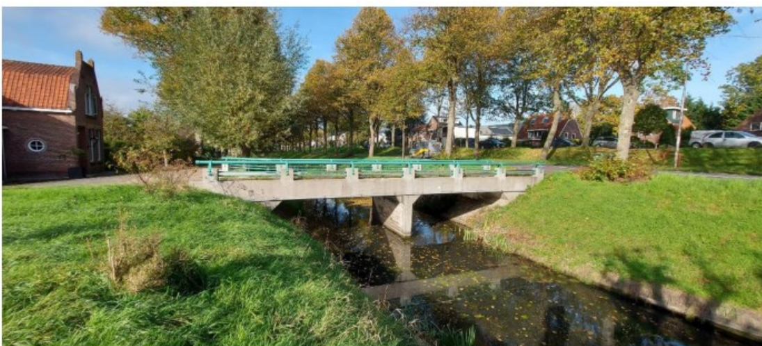
afb. 49 Betonnen brug met metalen liggers die toegang geeft tot onder meer het erf van Even Buiten
