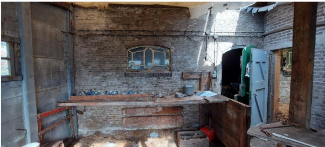
afb. 32 Boven zicht op de achtergevel op de verdieping, onder zicht op de achtergevel begane grond gezien vanuit de aanbouw C
