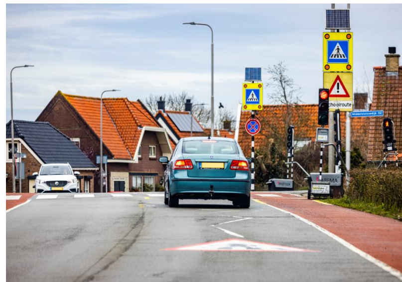
Figuur 4.14: tijdelijke verkeerslichten op centrale as in proefperiode
