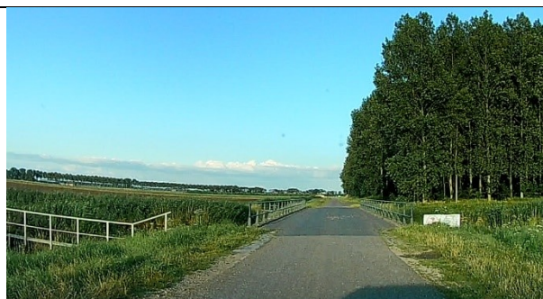
Brug in Lange Eendragtsweg
