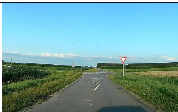
Voorrangskruispunt Dwarsweg - Lange Eendragtsweg
