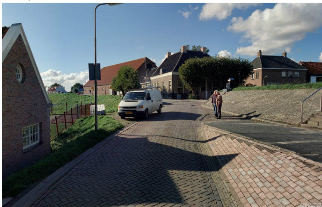
Foto: De Molendijk bij de aansluiting op de Westdijk en de haven (rechts).
