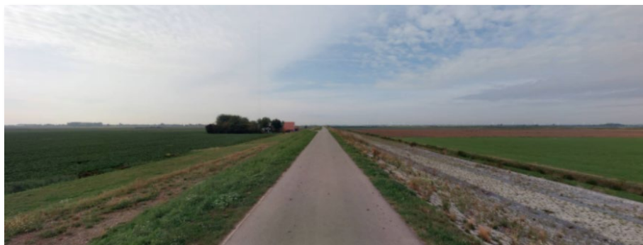
Figuur 3.5: Westdijk (bron: Cyclomedia).
