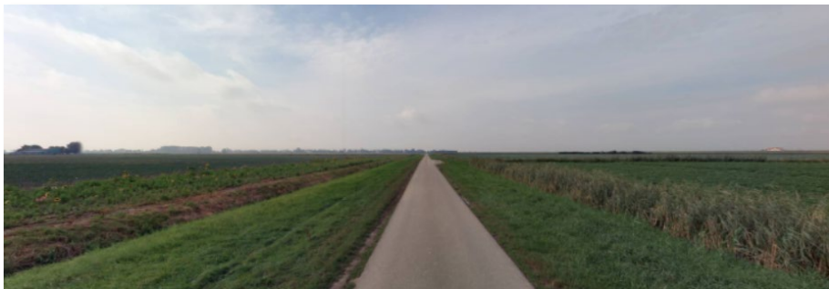
Figuur 3.6: Achterweg (bron: Cyclomedia).
