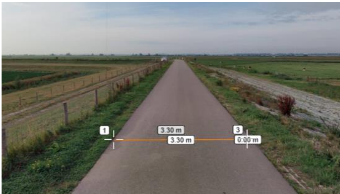
Figuur 12: Wegbreedte (globaal) van de Westdijk, gezien naar het zuiden.
