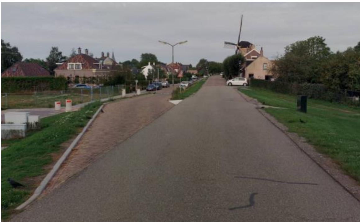
Figuur 4: Splitsing hoge (rechts) en lage deel (links) van de Molendijk, gezien richting het westen. Telpunt 3 ligt ongeveer 30 meter ten oosten van deze locatie (zie figuur 3).
