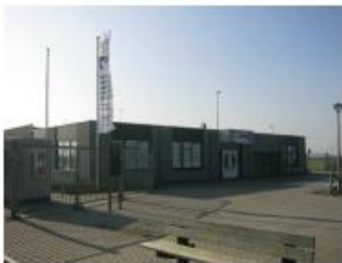
Bebouwing op Sportpark Kikkershoek van één bouwlaag met plat dak
