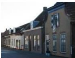
Gesloten bebouwingslint aan de Molenstraat
