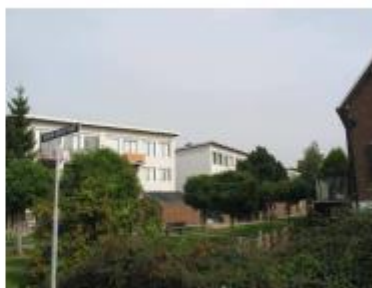
Gestapelde woonbebouwing met lesenaarsdak
