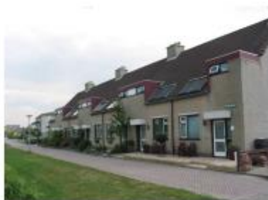
Rijtjeswoningen aan de Verweystraat, Mijnsheerenland
