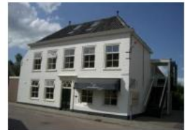
Klassieke vormgegeven gevels aan de Kerkstraat.
