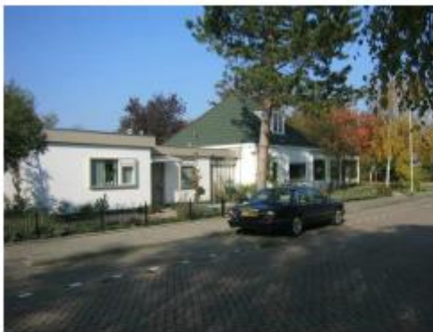
Vrijstaande woningen in één bouwlaag met en zonder kap, aan de Oleanderstraat
