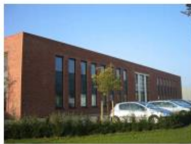
De bedrijfsbebouwing is opgebouwd uit metselwerk met ramen regelmatig in de gevel geplaatst
