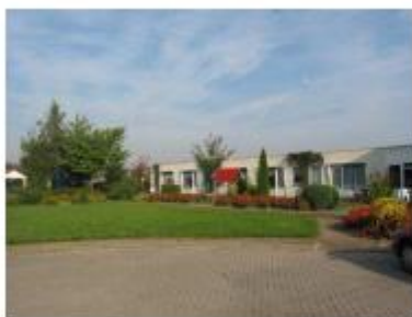
Het verzorgingscomplex bestaat uit één bouwlaag met plat dak
