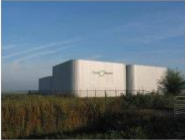
Nieuwe bedrijfsbebouwing opgebouwd uit damwandprofiel
