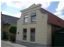
Klassieke ingezwenkte lijstgevel aan de Torenstraat.
