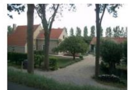
Beeld van woonbebouwing onderaan de dijk.
