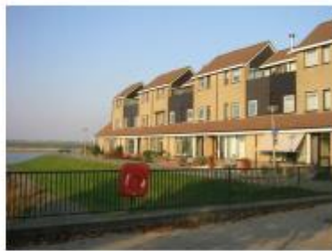
Bijzondere architectuur bij de woningen langs de Spui-oever
