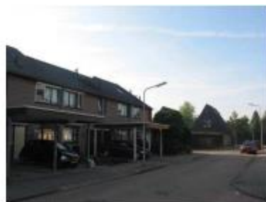
Carports bepalen het bebouwingsbeeld
