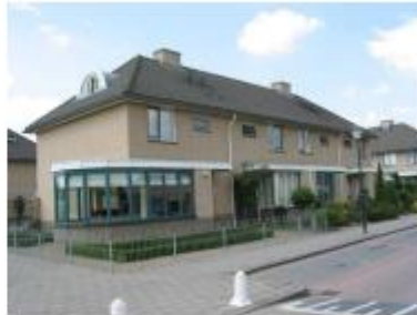
Woningen met een uitbouw aan de zijkant in Hofwijk, Mijnsheerenland
