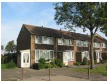
Houtwerk tussen de ramen van de begane grond en de eerste verdieping
