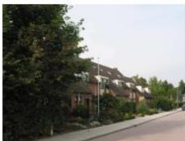
Differentiatie in de gevel door verschil in goothoogte
