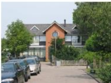
Variatie in gevelbeeld aan de De Ruyterstraat, Blaaksedijk
