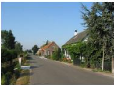
Dijkwoningen aan de Maasdamsedijk met de achterzijden naar de Boezemvliet
