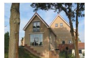
Nieuwbouw in de vorm van een dijkwoning aan de Molendijk
