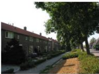
Rijtjeswoningen onderaan de Mollekade, gescheiden van de dijk door laanbeplanting, Blaaksedijk
