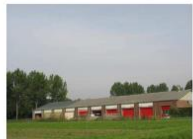
Schuur met opvallende kleuren zichtbaar vanaf de Boendersweg
