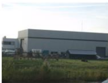
Vrijstaande loods in Piershil
