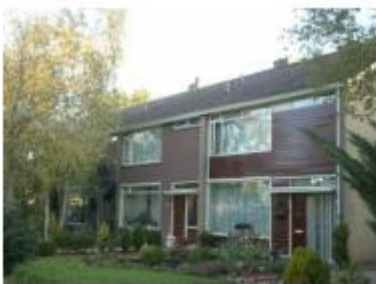
Verschiede gevelinvullingen verstoren de eenheid van het blok in Nieuw-Beijerland
