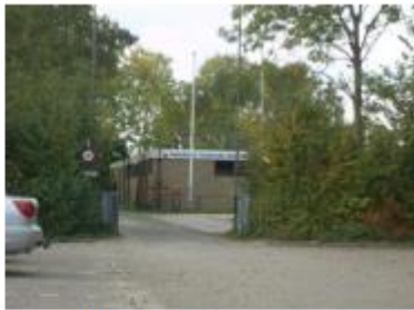
Gesloten gevelwanden achter de begroeiing in Zuid-Beijerland
