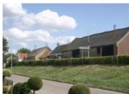
Duidelijke scheiding tussen bebouwing boven en onder aan de dijk.
