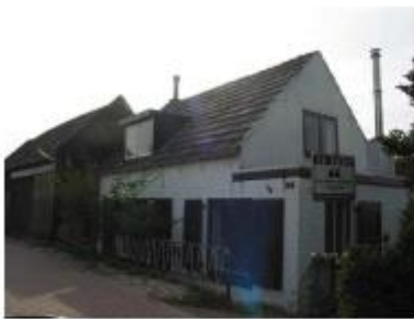
Zowel de woning als de schuur staan met de nokrichting evenwijdig aan de dijk
