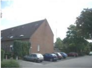
Asymmetrische dakvormen met gesloten kopgevels.
