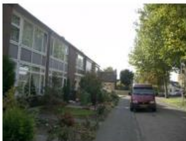
Prefab gevels met opvallend stijl en regelwerk in Goudswaard
