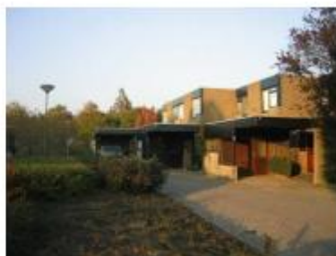
Geschaalde woningen met plat dak en een carport aan de Jan Tooropstraat
