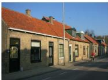
Bebouwing in één bouwlaag met kap aan de Steenenstraat
