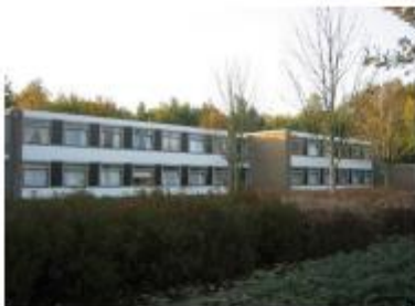
Twee bouwlagen met plat dak aan de Anton Maanstraat
