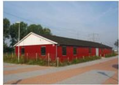
Rood houtwerk is beeldbepalend voor de bebouwing
