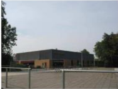
De sporthal bestaat uit de hal van damwandprofiel en een entreegebouw van metselwerk
