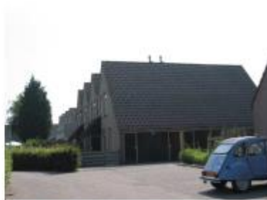
De nokrichting is loodrecht op de straat, Mijnsheerenland
