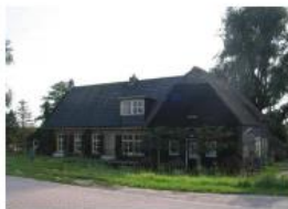
Historische boerderij bestaande uit een combinatie van pannen en een rieten dak en hout- en metselwerk
