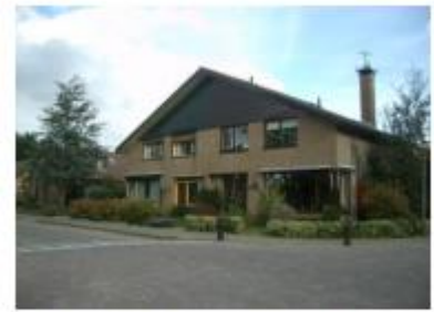
Twee-onder-één-kap woning in Zuid- Beijerland
