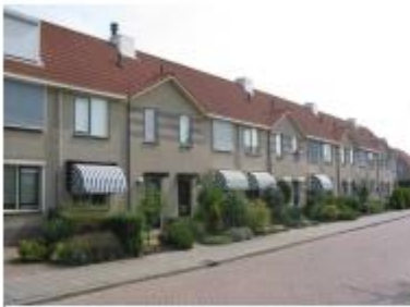
Ritmiek in de topgevels bij rijtjeswoningen, Puttershoek
