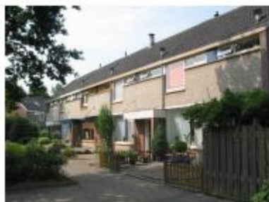
Raamindeling zorgt voor horizontale gevelgeleding en de woningen liggen aan een straat voor langzaam verkeer, Puttershoek
