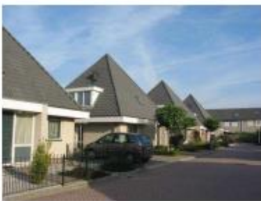
Vrijstaande woningen met piramidedak aan het Spuihof
