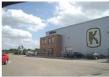
Representatieve architectuur bij het kantoorgebouw voor de loods.
