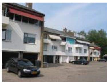
Drive-in woningen van drie bouwlagen
