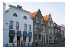
Historische gevel, waaronder trapgevels, aan de Havendam
