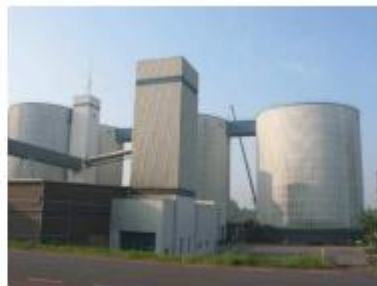
De hoge silo's zijn beeldbepalende elementen bij de suikerfabriek
