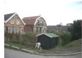
Fraai metselwerk bij bebouwing aan de Dorpsstraat in Zuid-Beijerland
