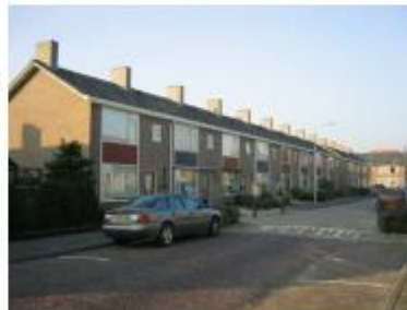
Rijteswoningen met plaatmateriaal tussen de ramen aan de Kottenaerstraat
