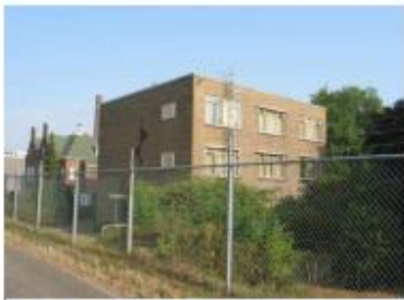
Gebouw aan de straatzijde op het fabrieksterrein
