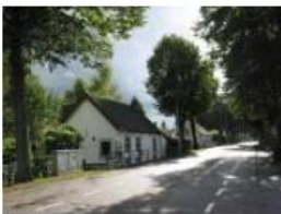
Een dijkwoning met gepleisterde gevels in Mookhoek
