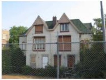
Gesloopte villa op het terrein van de suikerfabriek
