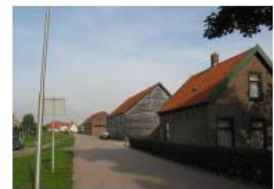
Houten schuur direct aan de dijk
