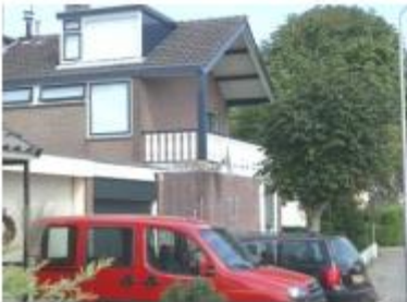
Bouwkundige toevoegingen op de kop van een bouwblok.
