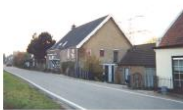
De dijk kent een smal profiel, waaraan direct bebouwing is gesitueerd
