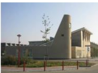
De kerk is een opvallende verschijning in de wijk, Bachlaan
