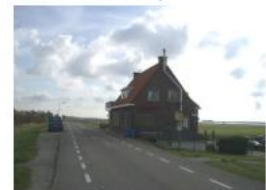
Gebouw markeert de ligging van Nieuwendijk aan het dijklint
