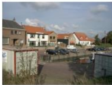
Gedifferentieerde straatwand aan de haven in Goudswaard
