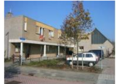
Op de begane grond zijn kolommen voor de woningen geplaatst, Sloobegor
