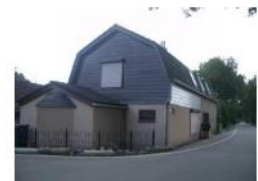
Bij kruisingen van dijk en polderweg ontstaat afwijkende bebouwing
