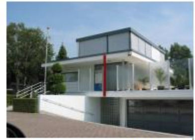
Opvallende vorm en kleurstelling aan de Vingerling, Mijsbeerenland
