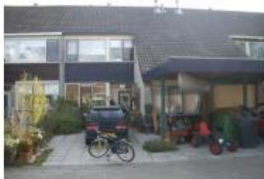
Doorstekende dakvlakken in Nieuwendijk
