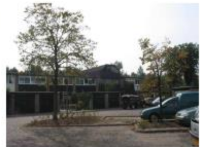
Enkele woningen hebben op het platte dak een uitbouw
