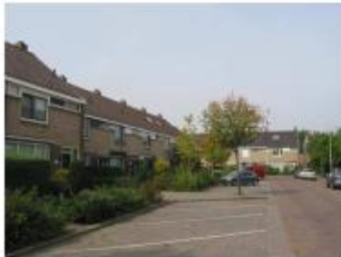
De vorm van de ramen op de eerste verdieping zorgen voor een horizontale gevelgeleding
