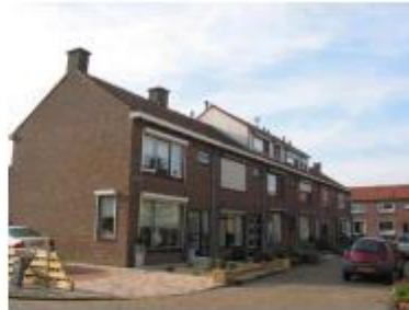
Op een aantal plaatsen komen dakkapellen voor
