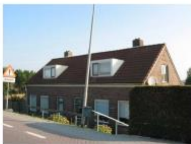
Bebouwing heeft vaak de nokrichting evenwijdig aan de weg
