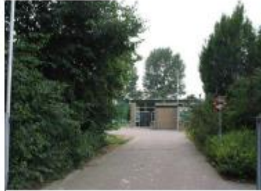
Bebouwing bij sportvelden van één bouwlaag
