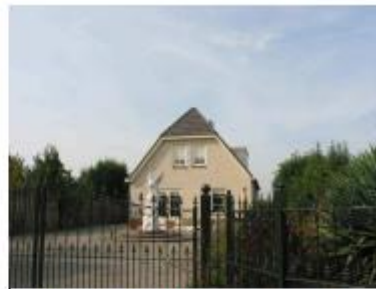
Vrijstaande woning met zadeldak met wolfreind in De Wacht
