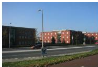
De kantoorgebouwen zijn allen opgetrokken uit roodbruin metselwerk
