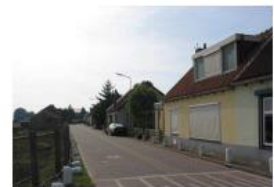
Gestructe gevels in het bebouwingslint
