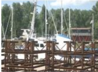
Karakteristiek beeld van de jachthaven en havenkantoor.
