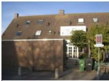
Bergingen vormen gesloten straatwanden
