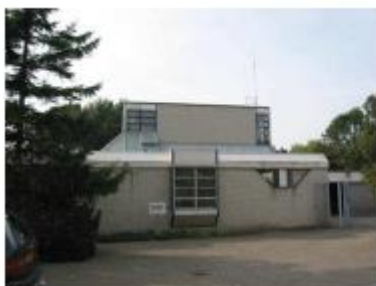
Het politiebureau kent een onregelmatige gevelindeling
