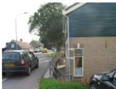
Verhoging van de dijk is op sommige plaatsen goed zichtbaar
