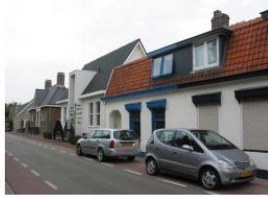
Historische en nieuwe bebouwing aan de Dorpsstraat
