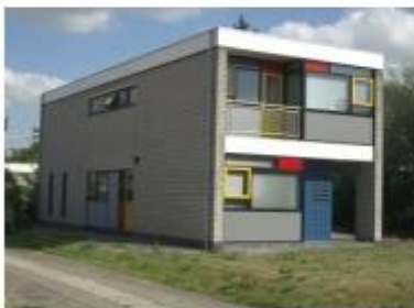
Individueel vormgegeven gebouw met verwijzingen naar "de Stijl".
