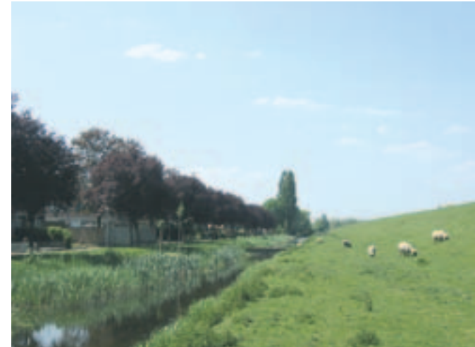
Primaire dijk zonder beplanting bij Heinenoord
