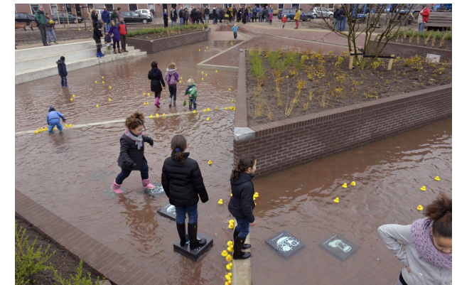
Openbare ruimte dat dient als berging bij piekbuien
